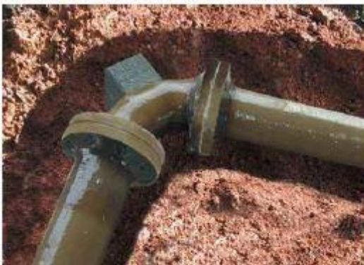
BLOCO DE ANCORAGEM NA VERTICAL
