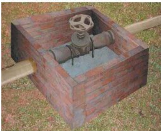
BLOCO PARA APOIO DE VÁLVULAS
