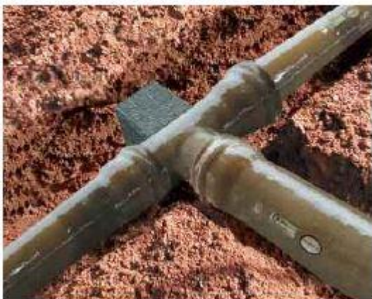
BLOCO PARA APOIO DE VÁLVULAS
